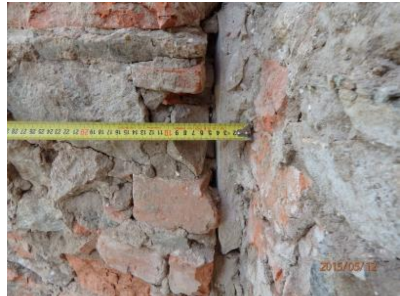
F 36 sakristie – napojení na stěnu kaple (SZ roh)
