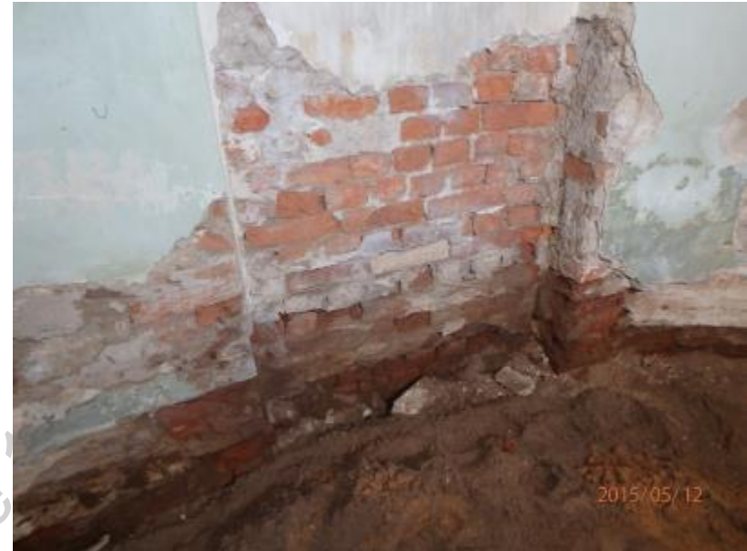
F 47 sakristie – cihelné zdivo, nad odstraněnou podlahou
