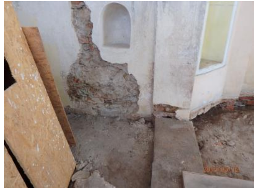
F 40 V stěna – odkryté smíšené zdivo
