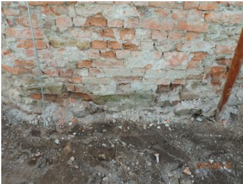
F 34 sakristie Z fasáda – cihelné zdivo
