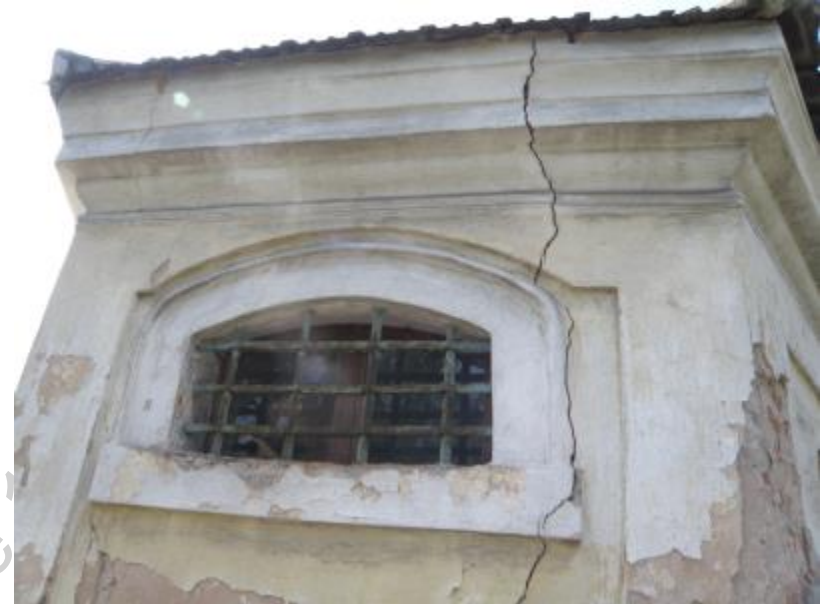
F 3 sákristie (přístavek) 23. 4. 2014 Severní fasáda
