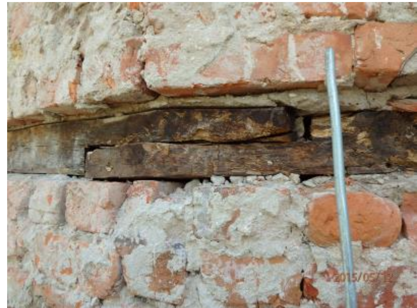
F 32 sakristie Z fasáda – spoj hranolu na SZ rohu
