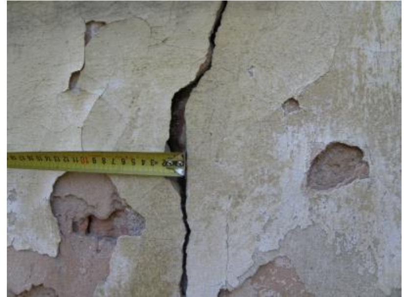
F 4 sákristie (přístavek) 23. 4. 2014 Severní fasáda
