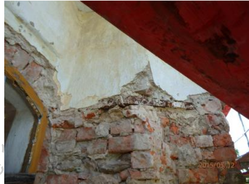
F 19 západní fasáda – ocelová pásovina za SZ rohem
