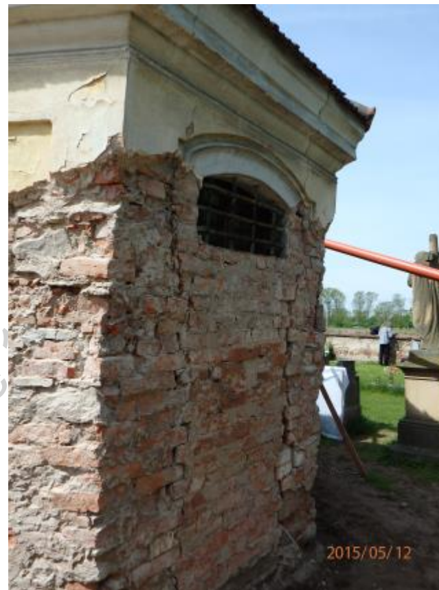
F 7 sákristie (přístavek) 12. 5. 2015 Severní fasáda
