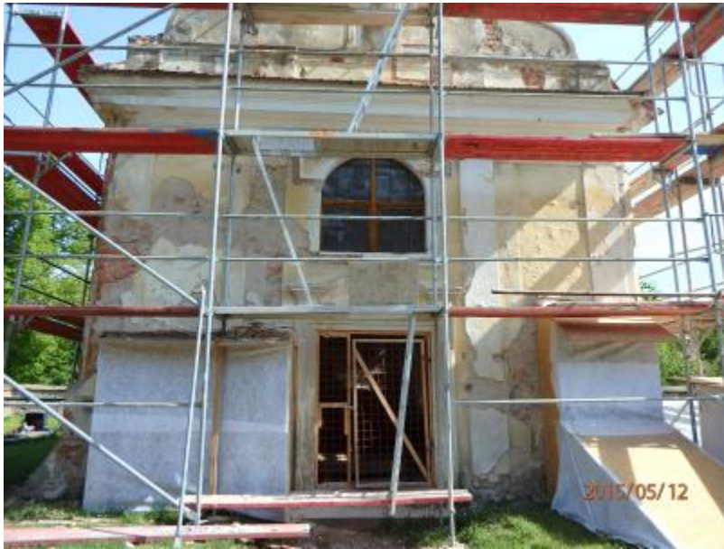
F 1 jižní fasáda
