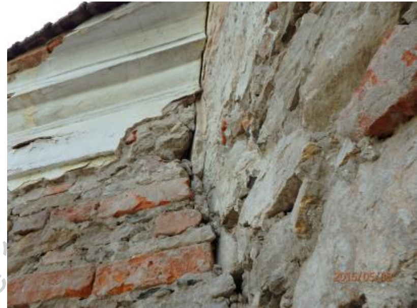
F 35 sakristie – napojení na stěnu kaple (SZ roh)
