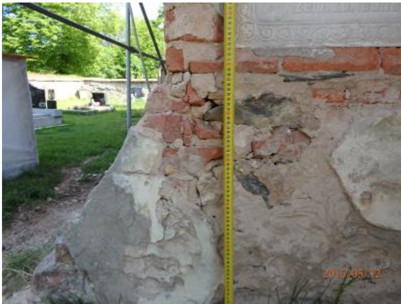
F 2 jižní fasáda JZ roh nad terénem
