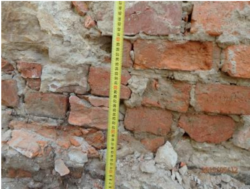
F 33 sakristie Z fasáda – cihelné zdivo
