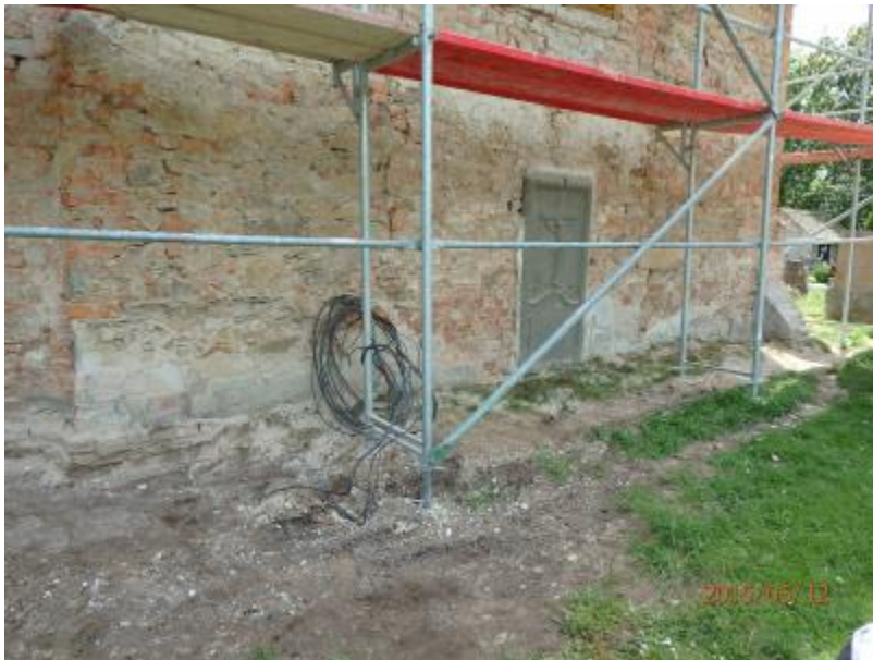
F 22 západní fasáda – dolní část zdiva
