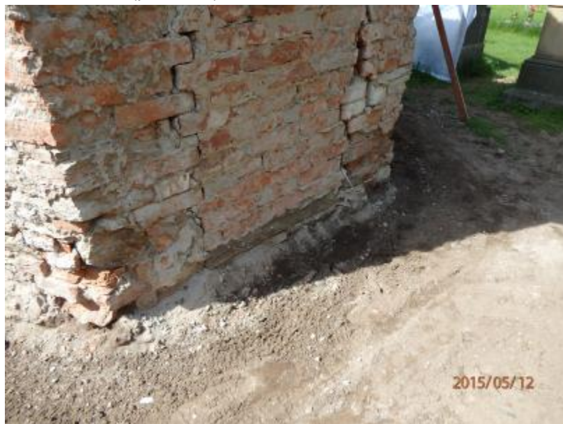
F 6 sákristie (přístavek) 12. 5. 2015 Severní fasáda
