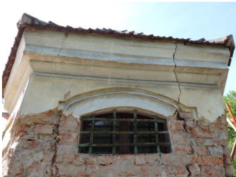
F 5 sákristie (přístavek) 12. 5. 2015 Severní fasáda
