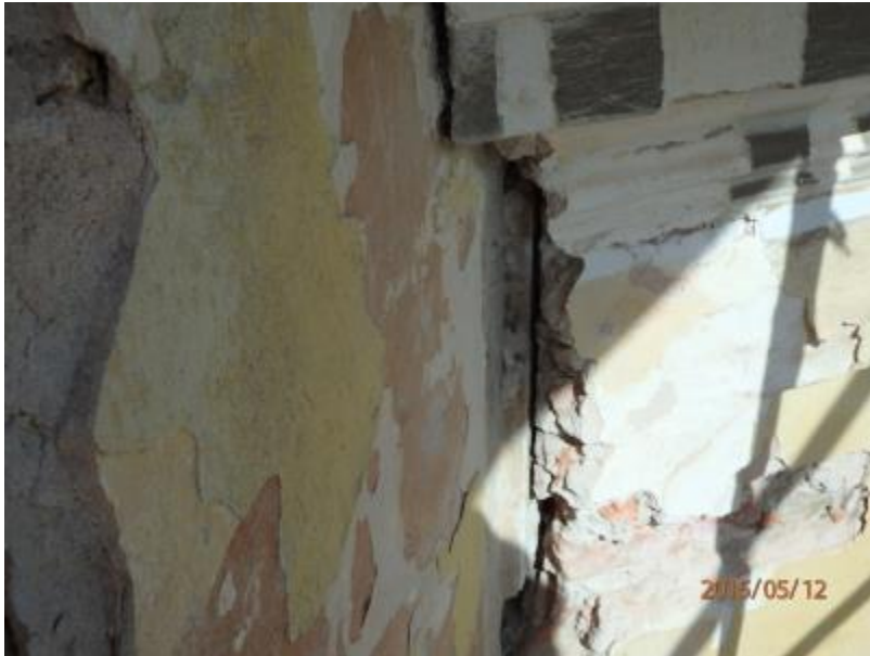
F 37 sakristie – napojení na stěnu kaple (SV roh)
