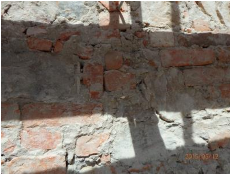
F 10 východní fasáda – vazba cihelného zdiva
