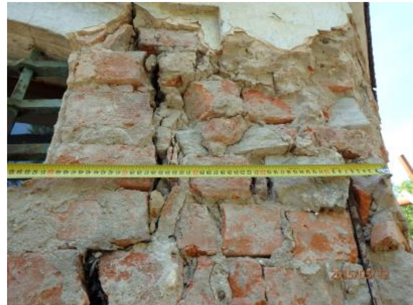
F 24 sakristie S fasáda – vazba zdiva
