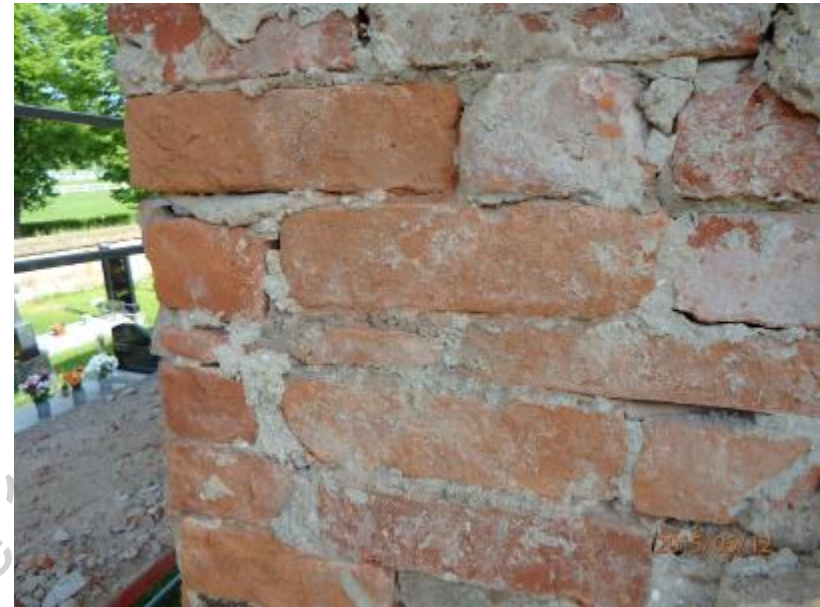
F 3 jižní fasáda – cihelné zdivo ve vyšší části - JZ roh
