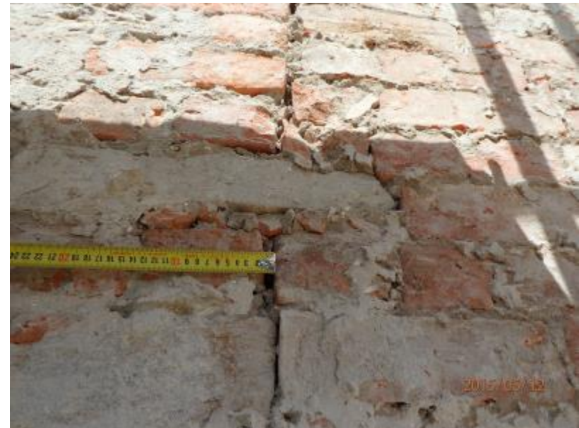
F 8 východní fasáda – provázání parapetního zdiva
