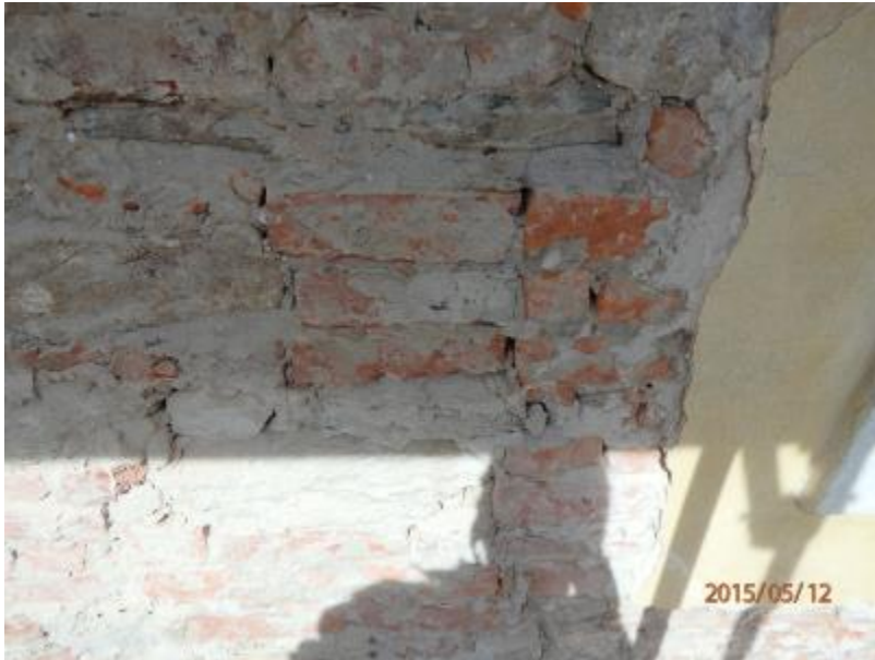
F 9 východní fasáda – vazba cihelného zdiva
