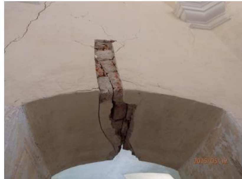
F 44 S stěna - průchod do přístavku
