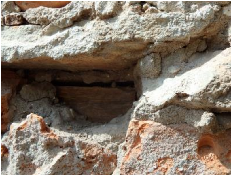
F 29 sakristie V fasáda – zazděný vodorovný hranol ve zdivu
