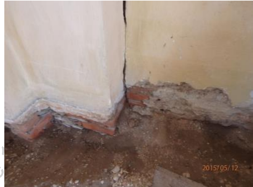
F 39 V stěna – napojení stěn
