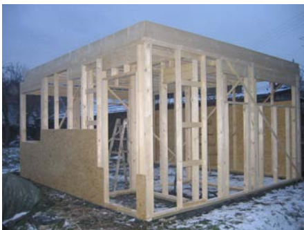
Vlevo hrubá stavba/krabice fošnové „two by four“. Listopad 2005.
