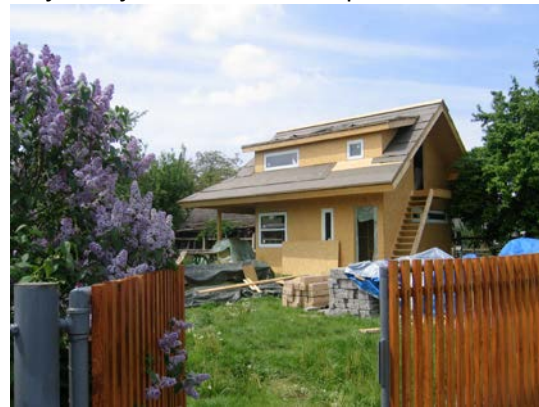
Jenomže chata rekonstruovat nešla, tak jsem začal stavět US systémem „TWO by FOUR“ chatu novou. Plot už je nový. 06/2006
