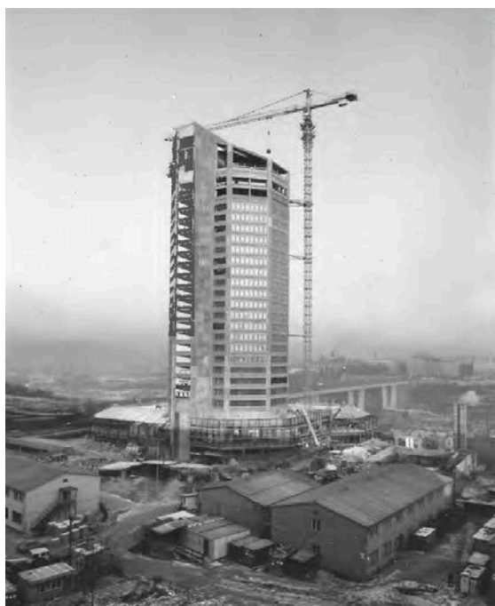
Pohled na dokončovanou stavbu hotelu v r. 1997, vpravo je hotová
